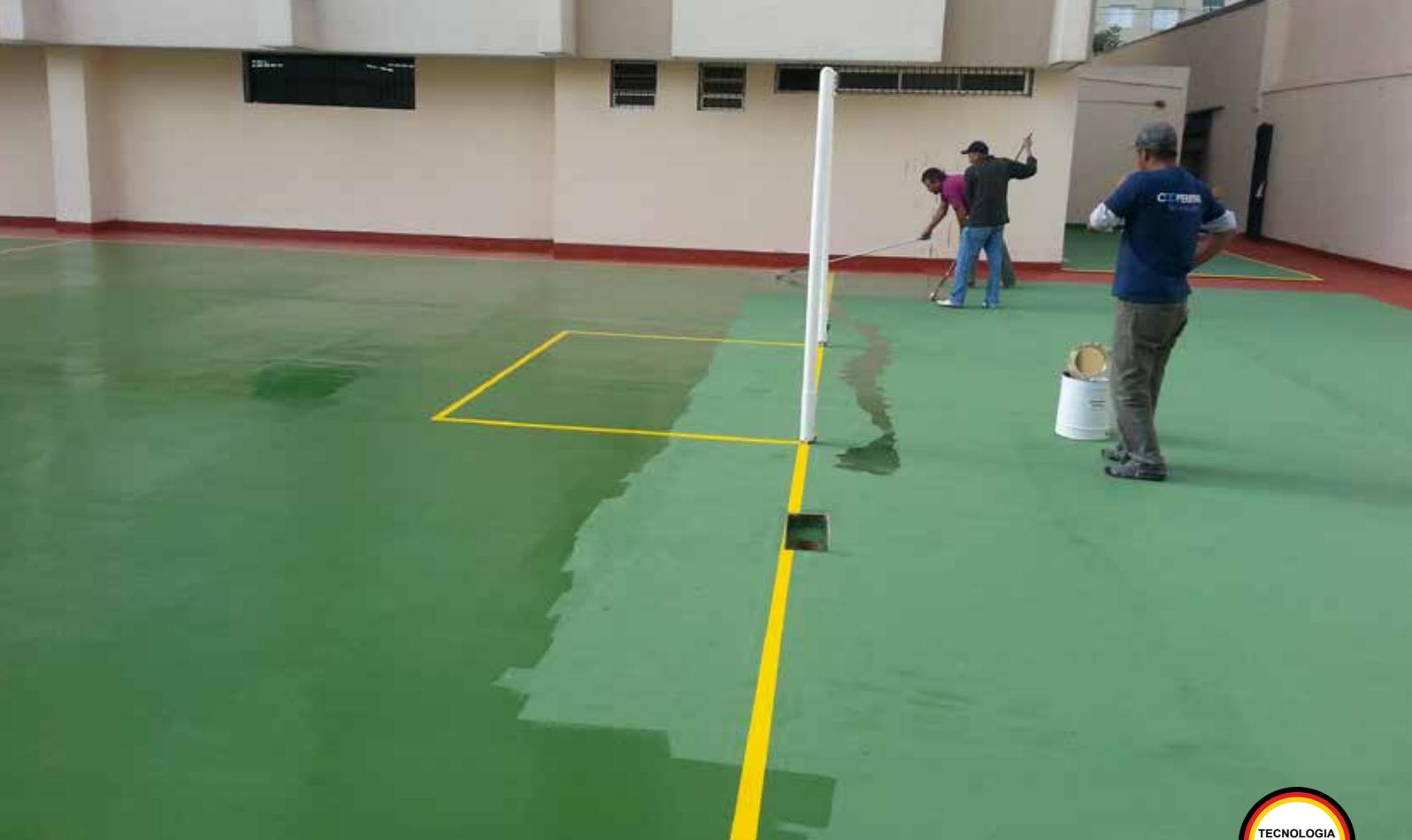
O verniz a base de MMA auxilia na proteção e acabamento estético da área impermeabilizada.
