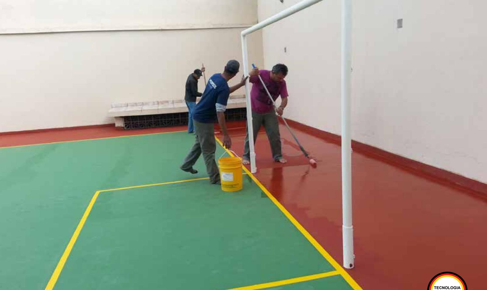
O acabamento Dur-A-Line MMA, além de estético, auxilia na proteção mecânica do sistema.
