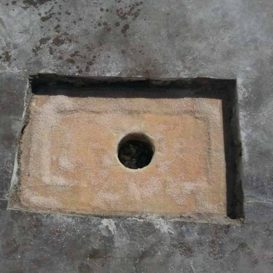
Os arremates em MMA em ralos e canos além de não diminuir a vazão, geram uma resistência maior.
