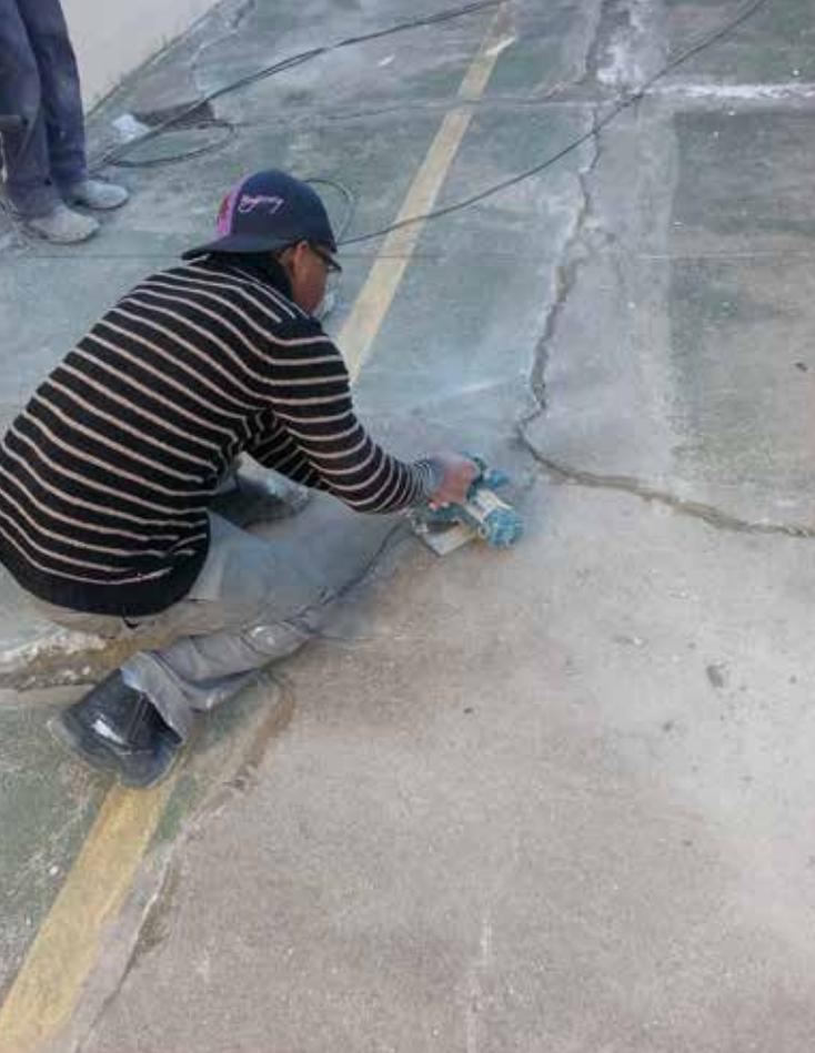
As trincas existentes foram abertas com serra mármore e tratadas com argamassa e tecido estruturante.
