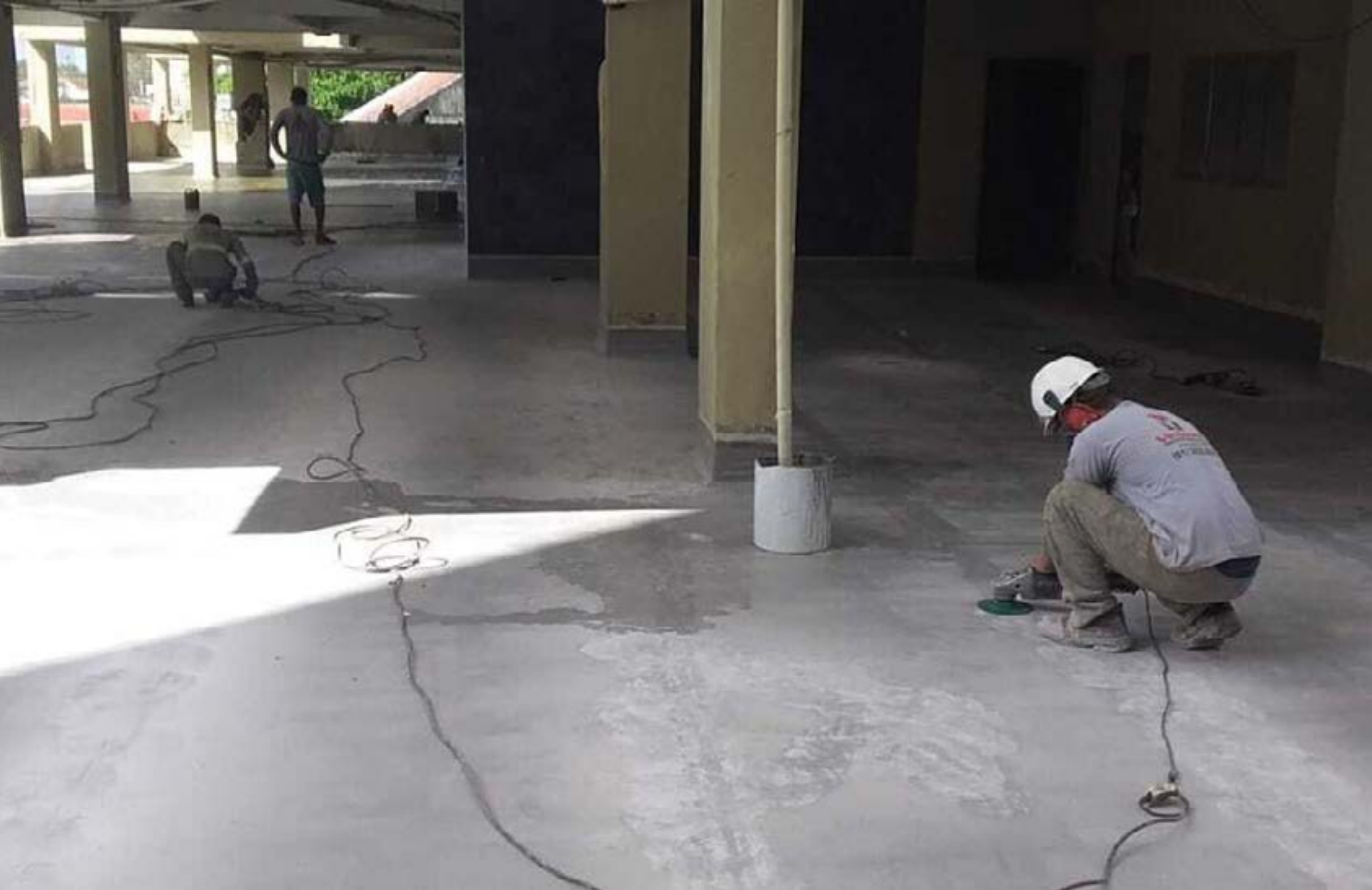
Preparação e regularização da base
