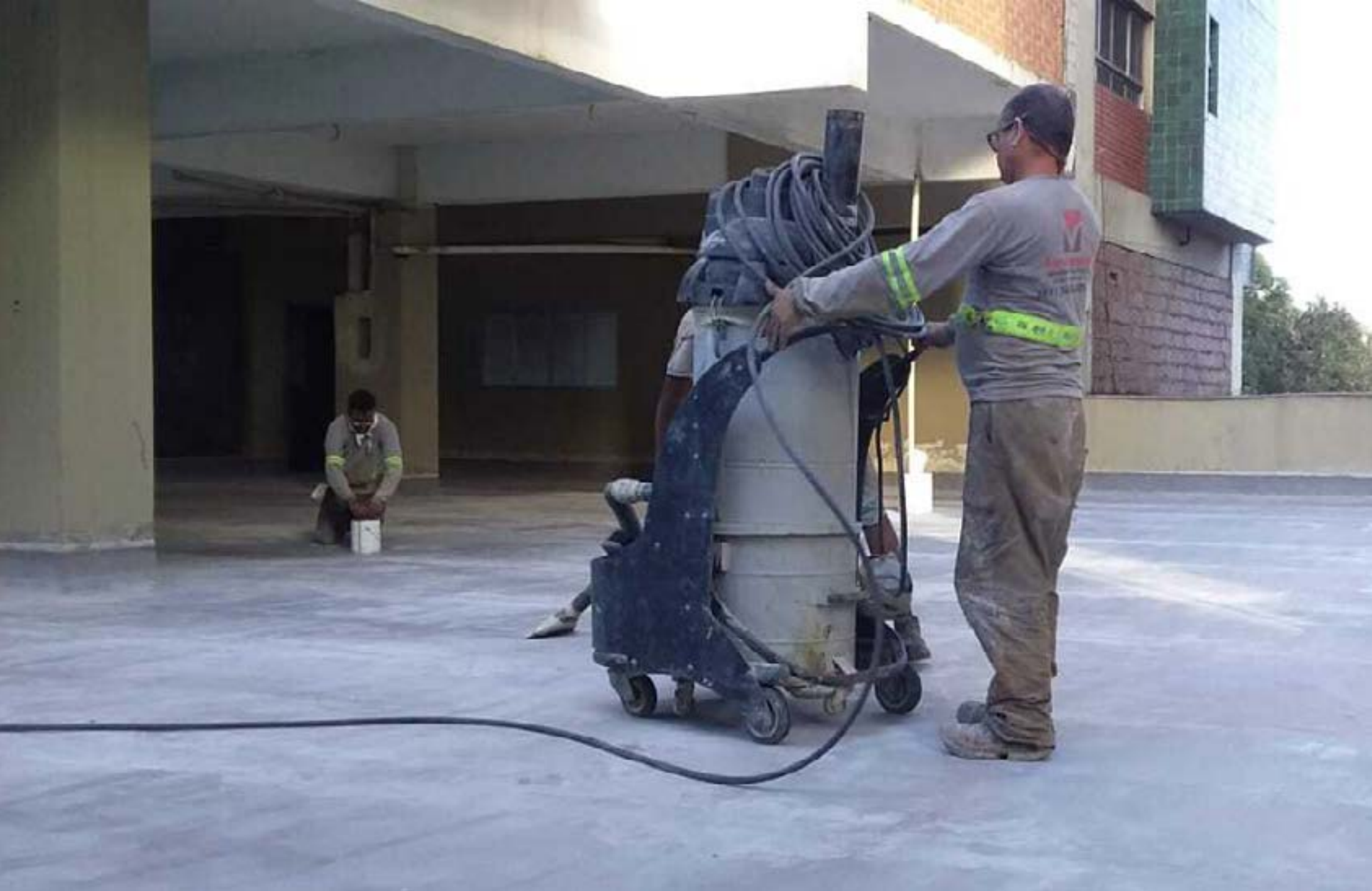
Limpeza da superfície
