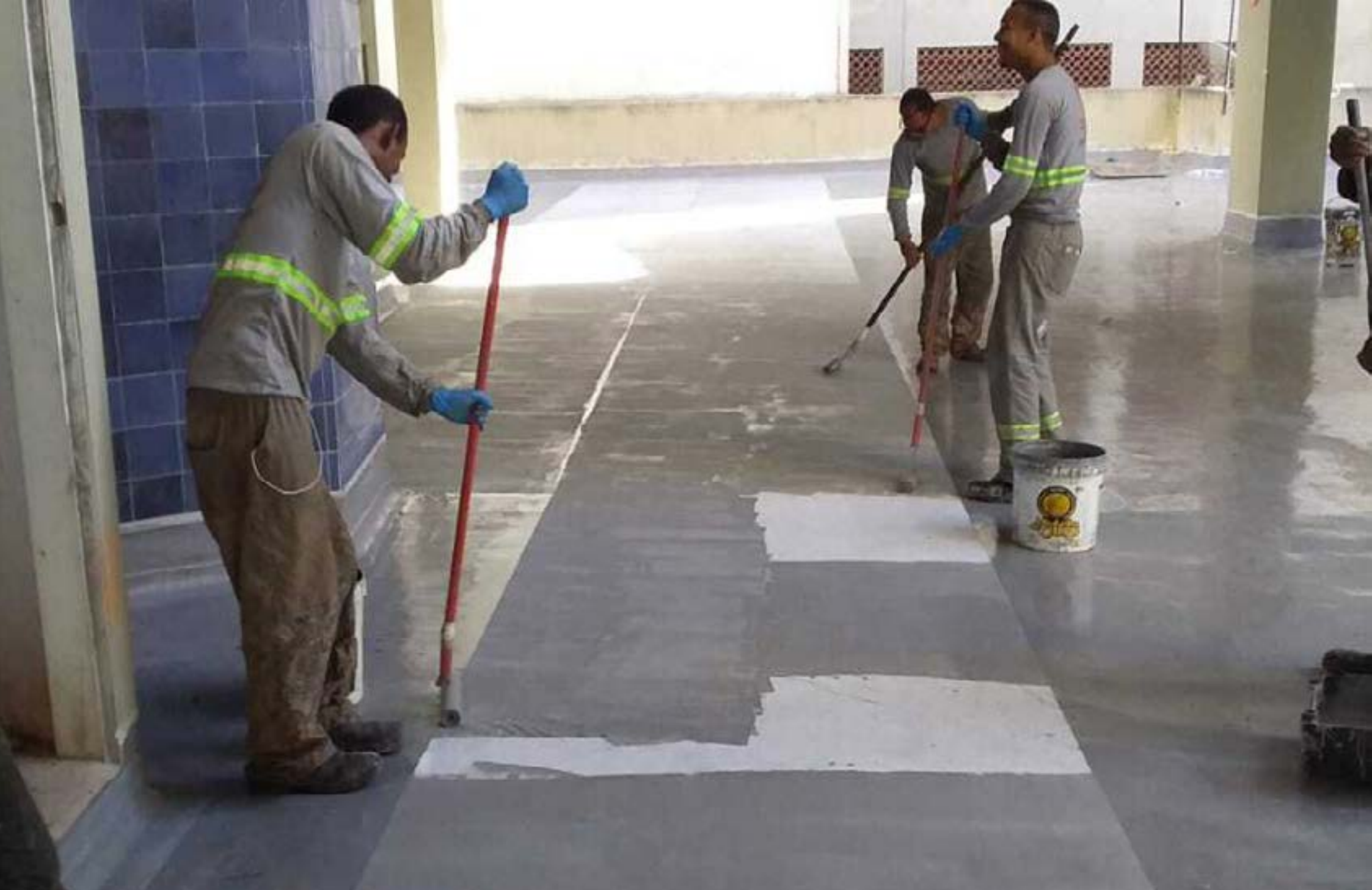
Aplicação da camada de acabamento Ureflex ST
