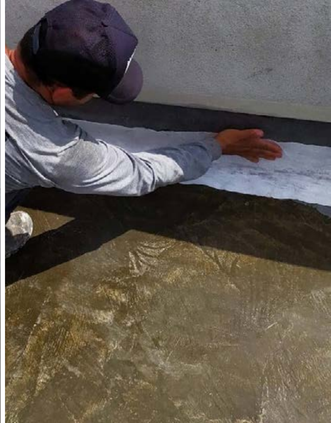
Aplicação do tecido estruturante em detalhes como: ralos, rodapés, tubulações e trincas
