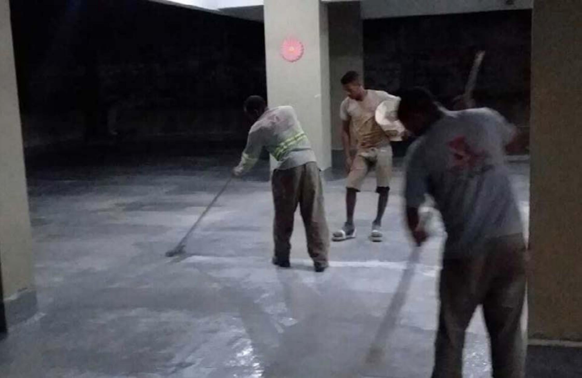
Aplicação da membrana flexível Ureflex M
