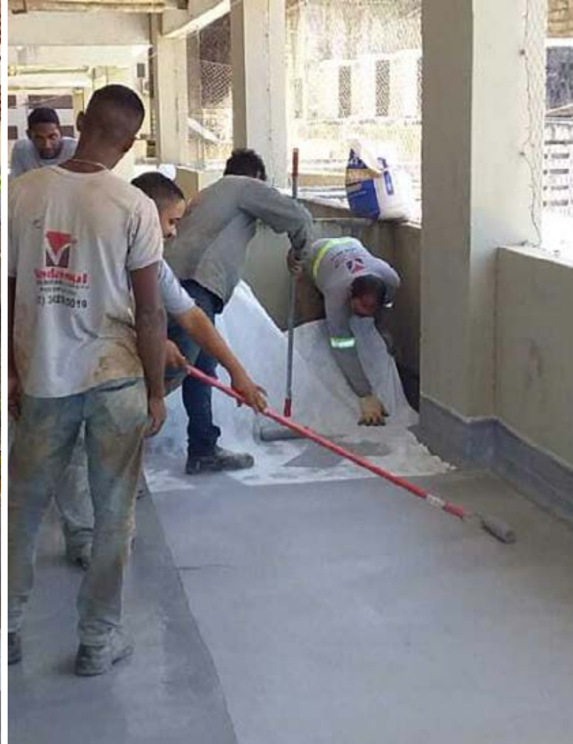
Aplicação do tecido estruturante em toda área
