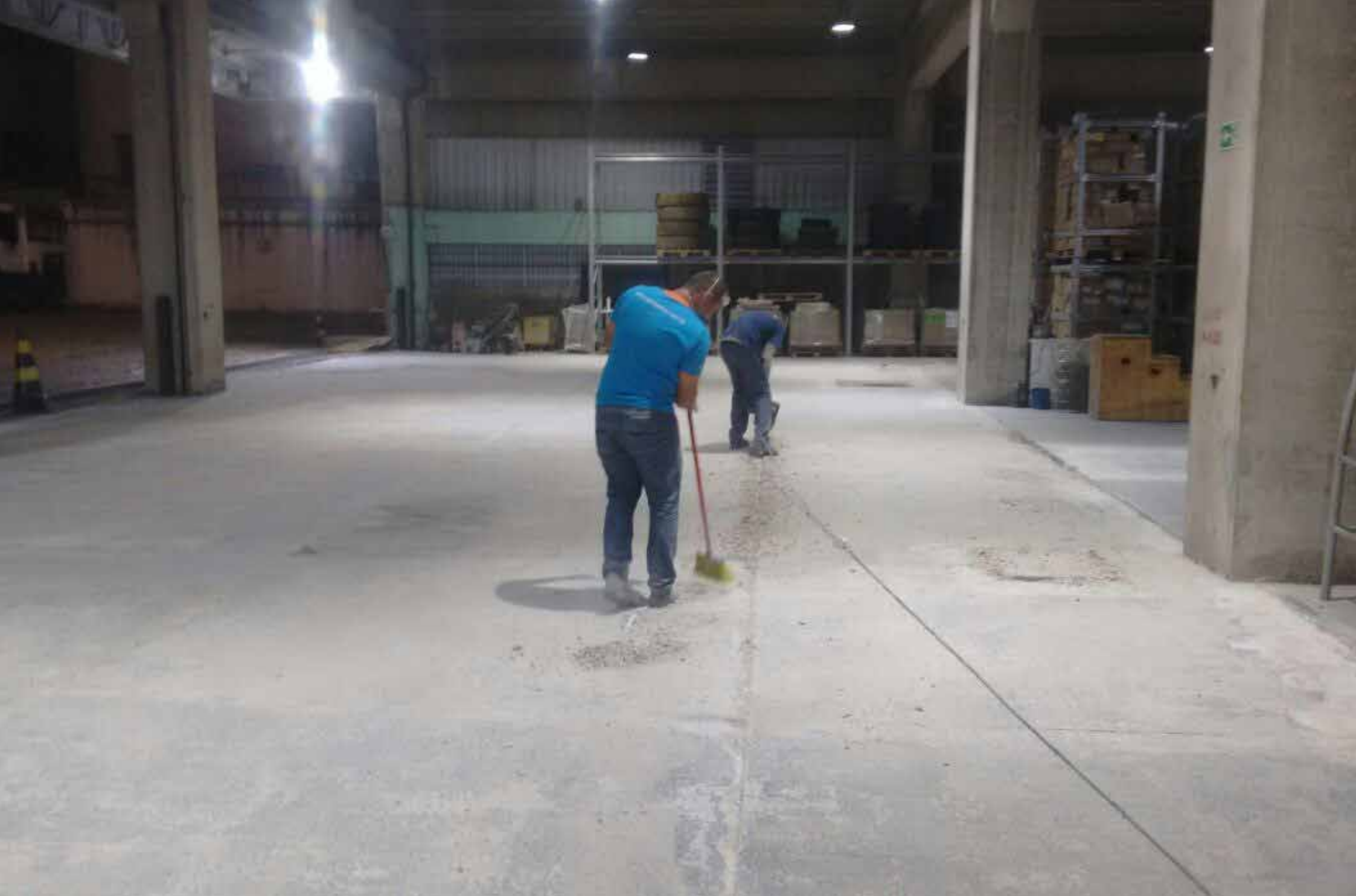
Limpeza da área para aplicação do revestimento
