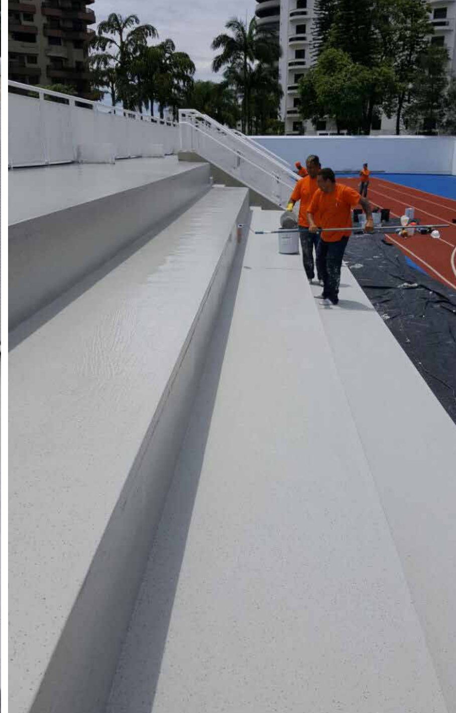
Aplicação do Verniz MMA / Acabamento
