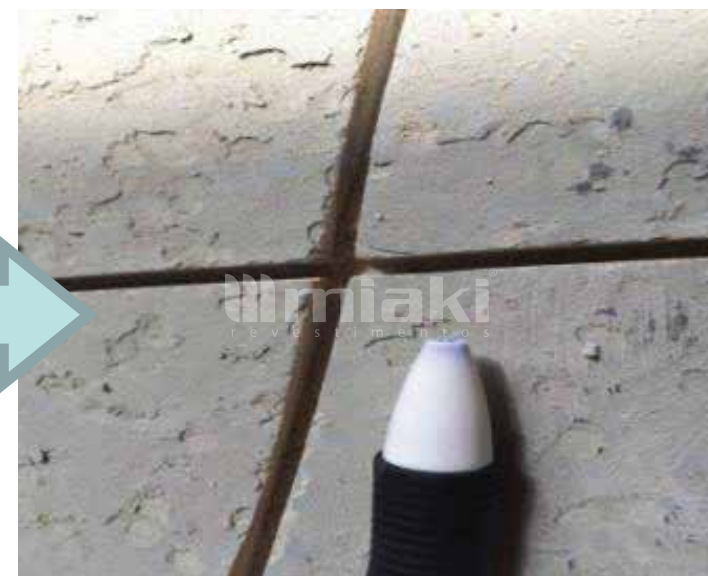
Detalhe Sulco ancoragem (evita o deslocamento)
