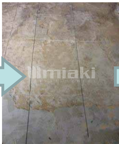
2. Execução de Sulcos ancoragem (melhora a aderência)
