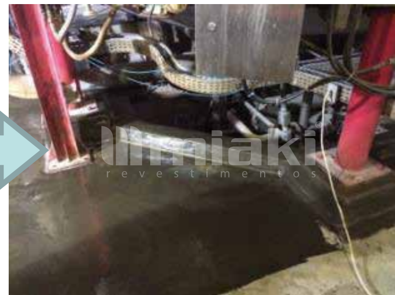
5. Aplicação de Primer Impermeabilizante
